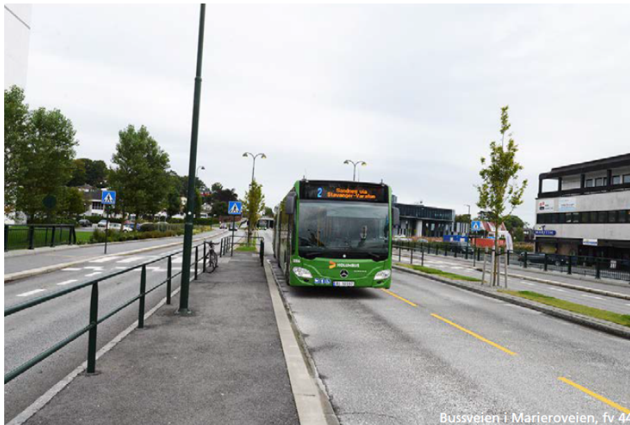
Figur 24 - Bilde som viser bussholdeplass til Bussveien. Planområdet ses i bakgrunnen. Kilde: Stedsanalysen til områdeplanen
