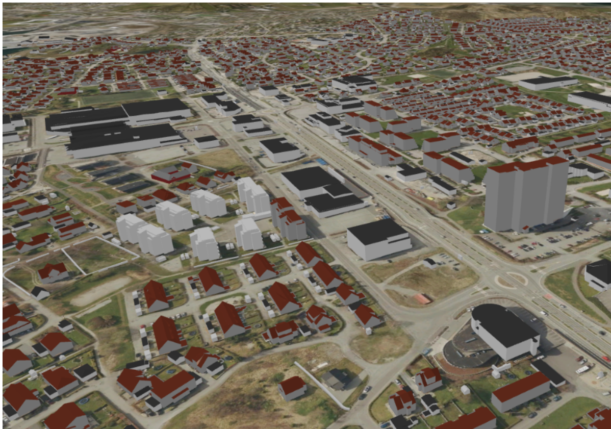
Figur 18 - Bebyggelsesstruktur. 3D som viser eksisterende bebyggelse i området. Sett fra nord med planområdet ved rundkjøring nede til høyre. Boliger er vist med røde tak, mens næringsbygg (og garasjer) er vist med sorte tak. Kilde: Kommune kart 3D
