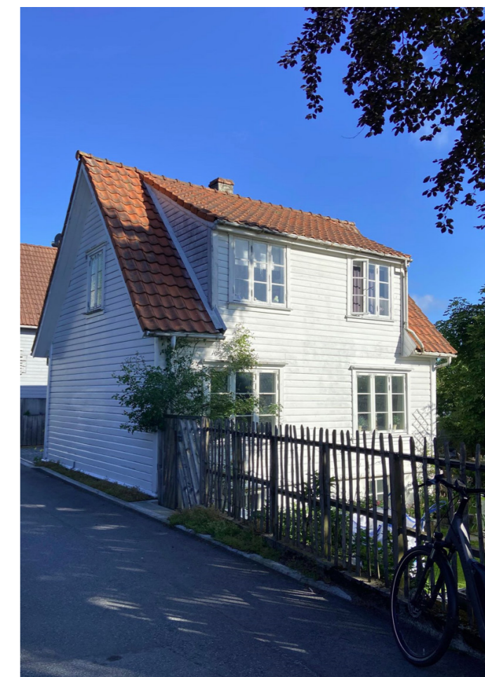
2. Bilde av sefrak-bolig i nord, lengst mot øst
