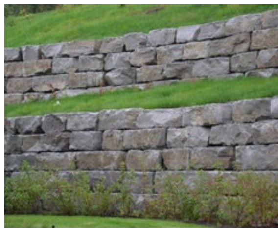
Figur 46 - Eksempel på utforming av todelt støttemur
